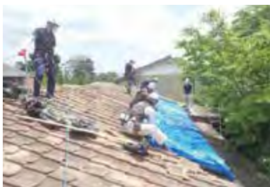
2021年5月、福島地震で崩壊した家屋の屋根の応急処置。災害ではまず雨漏をしのげるのが最優先。
