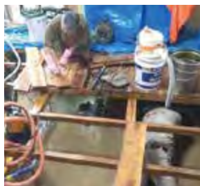
ポンプを駆使しての床下作業。水だけでなく泥が入るとかなり手間取る。
